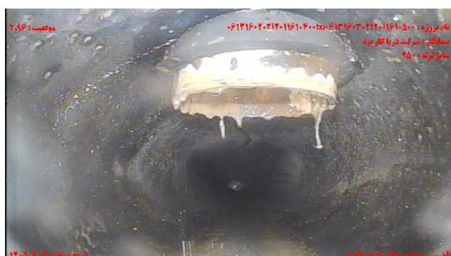
شماره تصویر ۳ عنوان موقعیت ۲۰۹۶ کد اتصال جانبی معيوب / اتصال معيوب انشعاب
