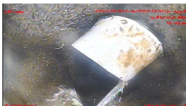
شماره تصویر ۴ عنوان موقعیت ۵۰۵۳ کد اتصال جانبی معيوب / انشعاب مهاجم - نفوذ به داخل لوله
