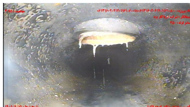
شماره تصویر ۴ عنوان اتصال جانبی معيوب / اتصال معيوب اشعاب موقعیت ۳۰۹۵ کد CX
