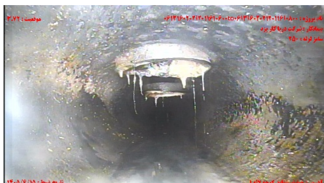
شماره تصویر ۳ عنوان اتصال جانبی معيوب / اتصال معيوب اشعاب موقعیت ۳۰۷۲ کد CX
