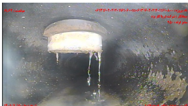
شماره تصویر ۵ عنوان اتصال جانبی معيوب / اشعاب مهاجم- نفوذ به داخل لوله موقعیت ۱۹۰۶۴ کد CXI درصد ۱۵
