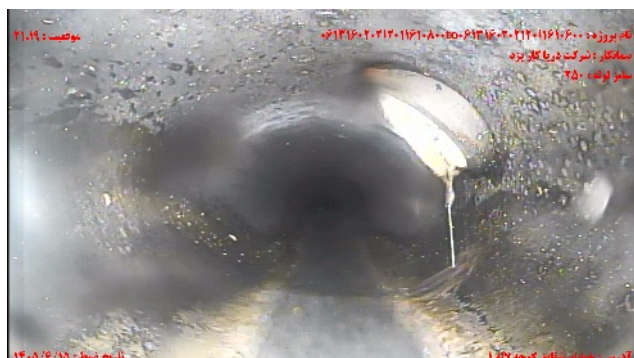
شماره تصویر ۵ عنوان اتصال جانبی معيوب / انشعاب مهاجم - نفوذ به داخل لوله موقعیت ۲۱.۱۹ کد CXI
