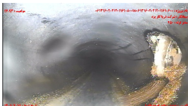
شماره تصویر ۴ عنوان نفوذ ریشه / نفوذ آبوه ریشه ها و گاهی سطح مقطع به میزان % درصد موقعیت ۱۷.۹۳ کد RM
