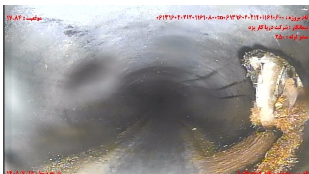
شماره تصویر ۳ عنوان اتصال جانبی معيوب / اتصال معيوب انشعاب موقعیت ۱۷.۸۴ کد CX
