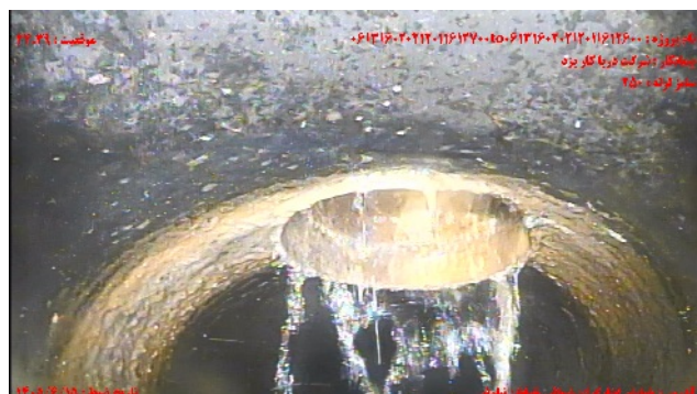
شماره تصویر ۶ عنوان محل اتصال انشعاب/اتصال انشعاب موقعیت ۲۴۰۳۹ کد CN
