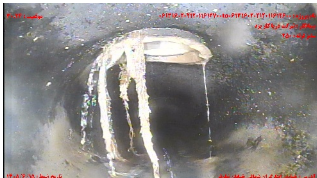
شماره تصویر ۷ موقعیت ۳۰.۲۴ کد CX عنوان اتصال حائمی معيوب / اتصال معيوب انشعاب
