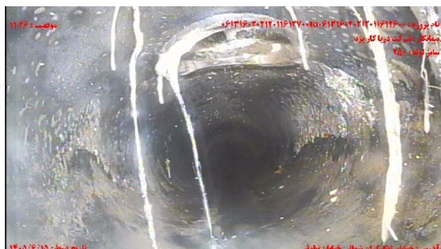
شماره تصویر ۵ عنوان محل اتصال انشعاب/اتصال انشعاب موقعیت ۱۱۰۲۶ کد CN
