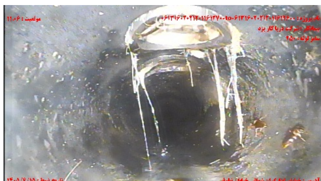
شماره تصویر ۳ عنوان اتصال جانبی معيوب/اتصال معيوب انشعاب موقعیت ۱۱۰۶ کد CX
