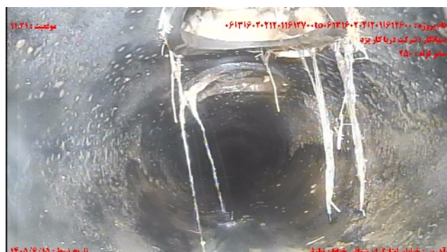
شماره تصویر ۴ عنوان نفوذ ریشه/نفوذ ریشه نازک موقعیت ۱۱۰۲۱ کد RF
