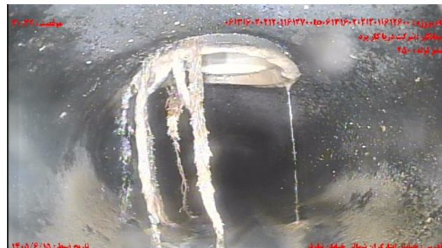
شماره تصویر ۸ موقعیت ۳۰.۳۲ کد RF عنوان نفوذ ریشه / نفوذ ریشه نا: ک
