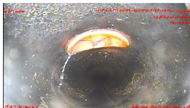
شماره تصویر ۴ عنوان موقعیت ۸۰۵۲ کد محل اتصال انشعاب / اتصال انشعاب CN
