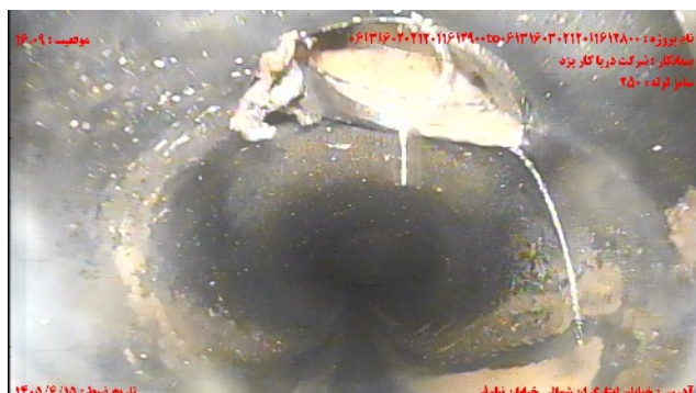
شماره تصویر ۵ عنوان موقعیت ۱۶۰۹ کد اتصال جانبی معيوب / اتصال معيوب انشعاب CX
