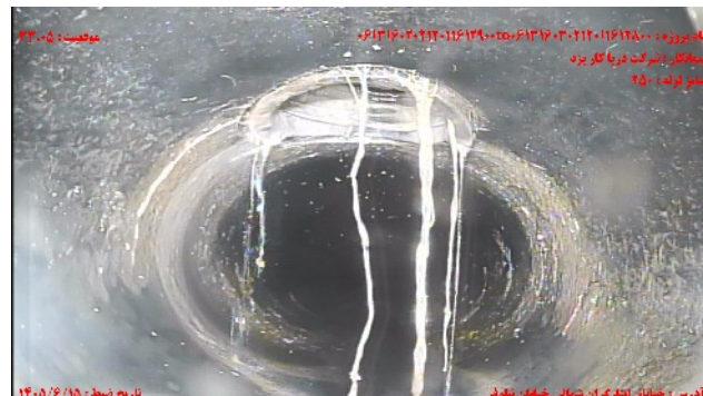
شماره تصویر ۸ عنوان نفوذ ریشه/نفوذ ریشه نازک موقعیت ۳۳۰۵ کد RF
