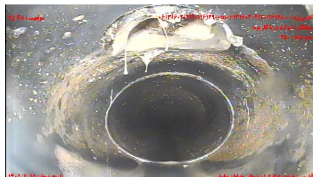
شماره تصویر ۶ عنوان موقعیت ۲۵۰۴۸ کد اتصال جانبی معيوب / اتصال معيوب انشعاب CX
