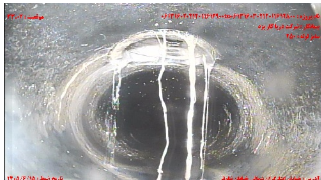
شماره تصویر ۷ عنوان اتصال جانبی معيوب/اتصال معيوب انشعاب موقعیت ۳۳۰۲ کد CX
