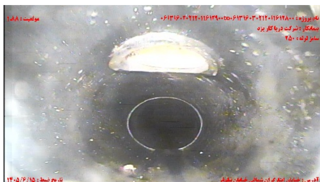
شماره تصویر ۳ عنوان موقعیت ۱۰۸۸ کد اتصال جانبی معيوب / اتصال معيوب انشعاب CX
