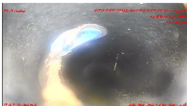
شماره تصویر ۹ عنوان نفوذ ریشه / نفوذ انبوه ریشه ها و کاهشی سطح مقطع به میزان ٪ موقعیت ۳۷.۰۹ کد RM درصد ۱۰
