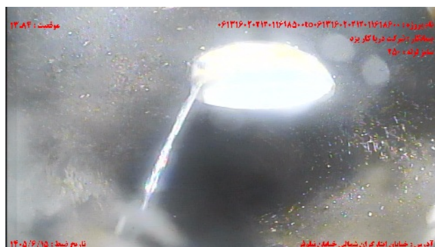
شماره تصویر ۴ عنوان موقعیت ۱۳۰۸۴ کد اتصال جانبی معيوب / اتصال معيوب انشعاب CX
