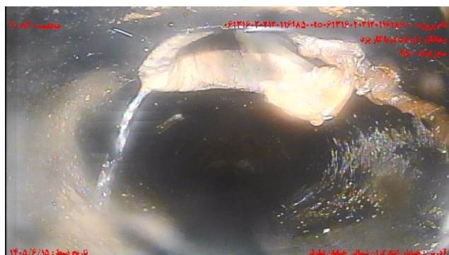
شماره تصویر ۵ عنوان موقعیت ۲۰۸۴ کد اتصال جانبی معيوب / اتصال معيوب انشعاب CX
