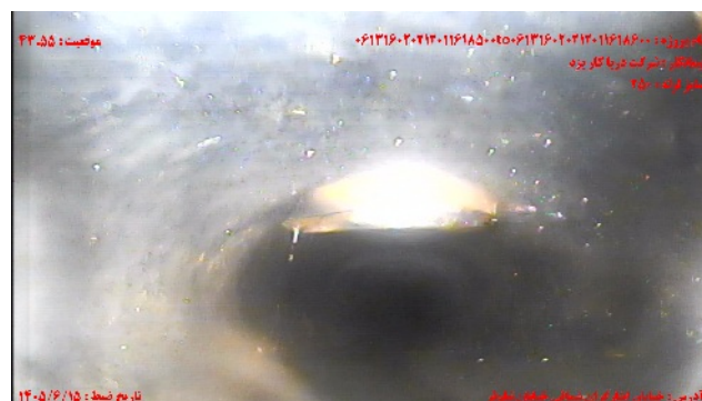
شماره تصویر ۱۰ عنوان اتصال جانبی معيوب / اتصال معيوب انشعاب موقعیت ۴۳.۵۵ کد CX
