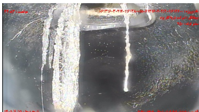
شماره تصویر ۹ عنوان نفوذ ریشه/نفوذ انبوه ریشه ها و کاهشی سطح مقطع به میزان % موقعیت ۴۴.۸۳ کد RM درصد ۱۰
