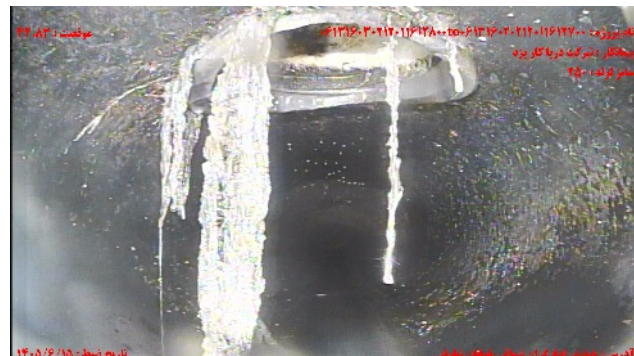
شماره تصویر ۸ عنوان اتصال جانبی معيوب/اتصال معيوب انشعاب موقعیت ۴۴.۸۳ کد CX
