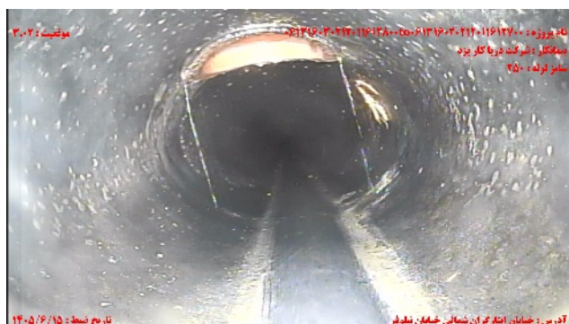
شماره تصویر ۳ عنوان موقعیت ۳۰۰۲ کد محل اتصال انشعاب / اتصال انشعاب
