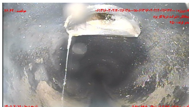
شماره تصویر ۶ عنوان موقعیت ۲۶۰۲۴ کد محل اتصال انشعاب / اتصال انشعاب
