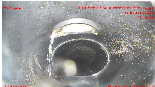
شماره تصویر ۷ عنوان محل اتصال انشعاب/اتصال انشعاب موقعیت ۳۷.۰۲ کد CN
