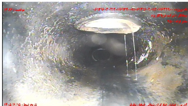
شماره تصویر ۷ موقعیت ۱۳.۹۲ کد CX عنوان اتصال جانبی معيوب/اتصال معيوب انشعاب
