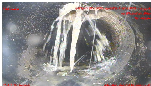
شماره تصویر ۳ عنوان اتصال جانبی معيوب / اتصال معيوب انشعاب موقعیت ۲۰۵۸ کد CX
