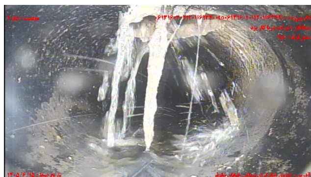
شماره تصویر ۴ عنوان نفوذ ریشه / نفوذ ریشه نازک موقعیت ۲۰۵۸ کد RF
