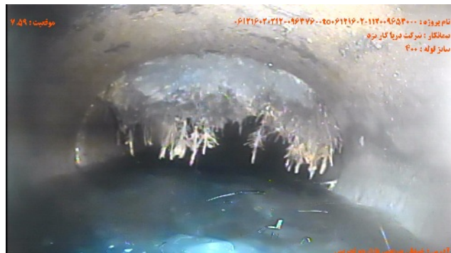
شماره تصویر ۸ موقعیت ۷.۵۹ کد OJ عنوان اتصال باز / به میزان % قطر
