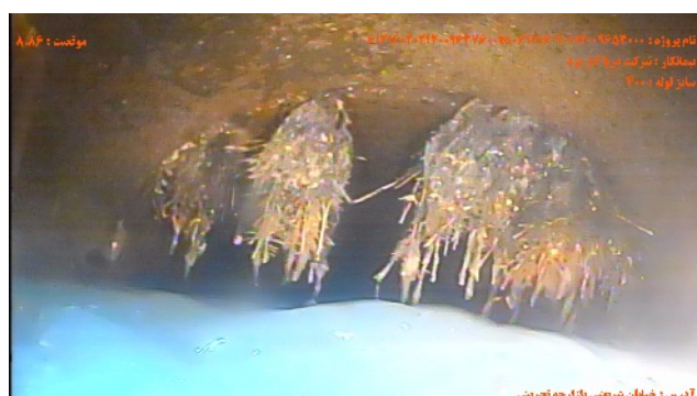
شماره تصویر ۱۰ موقعیت ۸.۸۶ کد OJ عنوان اتصال باز / به میزان % قطر
