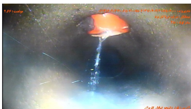
شماره تصویر ۳ عنوان موقیعت ۲۰۶۶ کد اتصال جانبی معيوب / انشعاب مهاجم- نفوذ به داخل لوله CXI
