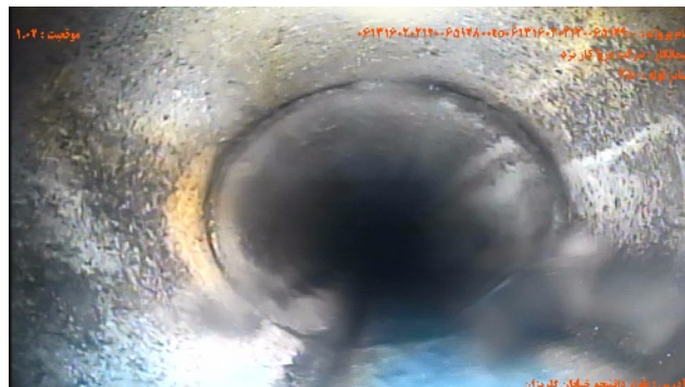
شماره تصویر ۲ عنوان WLT موقعیت ۱۰۰۲ کد تراز آب / تراز آب کدر درصد ۵
