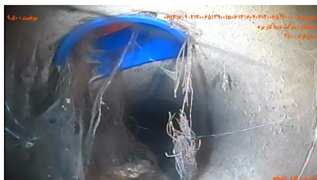
شماره تصویر ۴ عنوان موقعیت ۹۰۵۰ کد نفوذ ریشه / نفوذ آبوه ریشه ها و گاهی سطح مقطع به میزان % درصد ۱۰ RM
