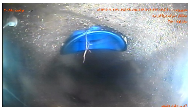
شماره تصویر ۵ عنوان موقعیت ۴۰۰۹۸ کد اتصال جانبی معيوب / اتصال معيوب انشعاب CX
