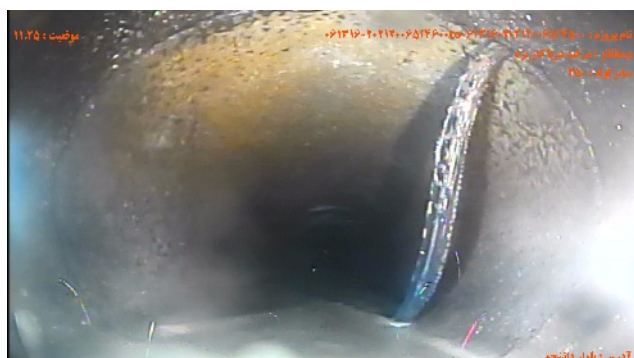
شماره تصویر ۳ عنوان آب بند معيوب/ورود و اثر آب بند به فضای داخل لوله—مهاجم موقعیت ۱۱.۲۵ کد SR
