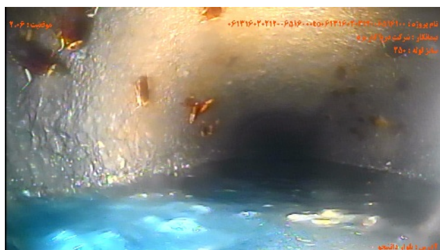
شماره تصویر ۳ عنوان رسوبات / سایر رسوبات ته نشین شده موقعیت ۲۰۶ کد DEX درصد ۱۰
