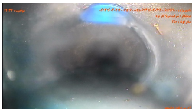
شماره تصویر ۵ عنوان محل اتصال اشعاب / اتصال اشعاب موقعیت ۱۲.۳۴ کد CN
