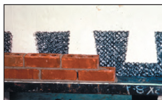
ب- وسیله مهار ملات که در فضای خالی نصب شده است.
