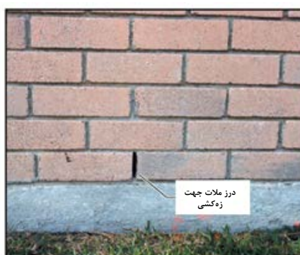
شکل ۵-۱۳- خالی گذاشتن درز ملات جهت زه‌کشی
