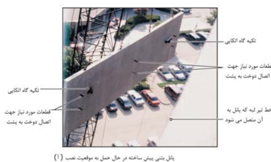
شکل ۷-۱۰- نمونه‌ای از اتصال دوخت به پشت
